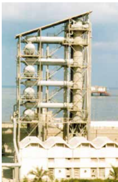
双塔式 4 级顺流桥式设计，非自立结构
