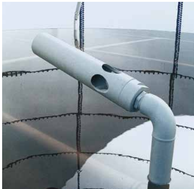
脱硝混合喷嘴
