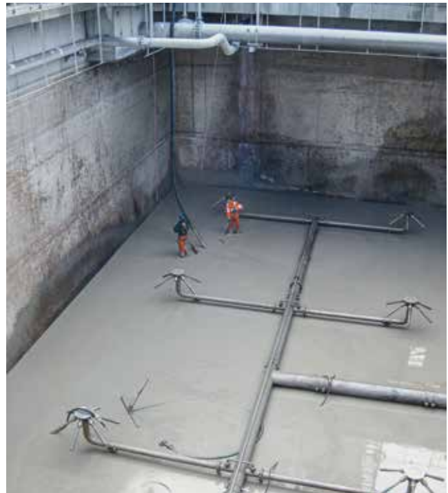
纯氧传递系统安装于德国Gebr.Lang GmbH造纸厂。使用6通路纯氧射流曝气器。
