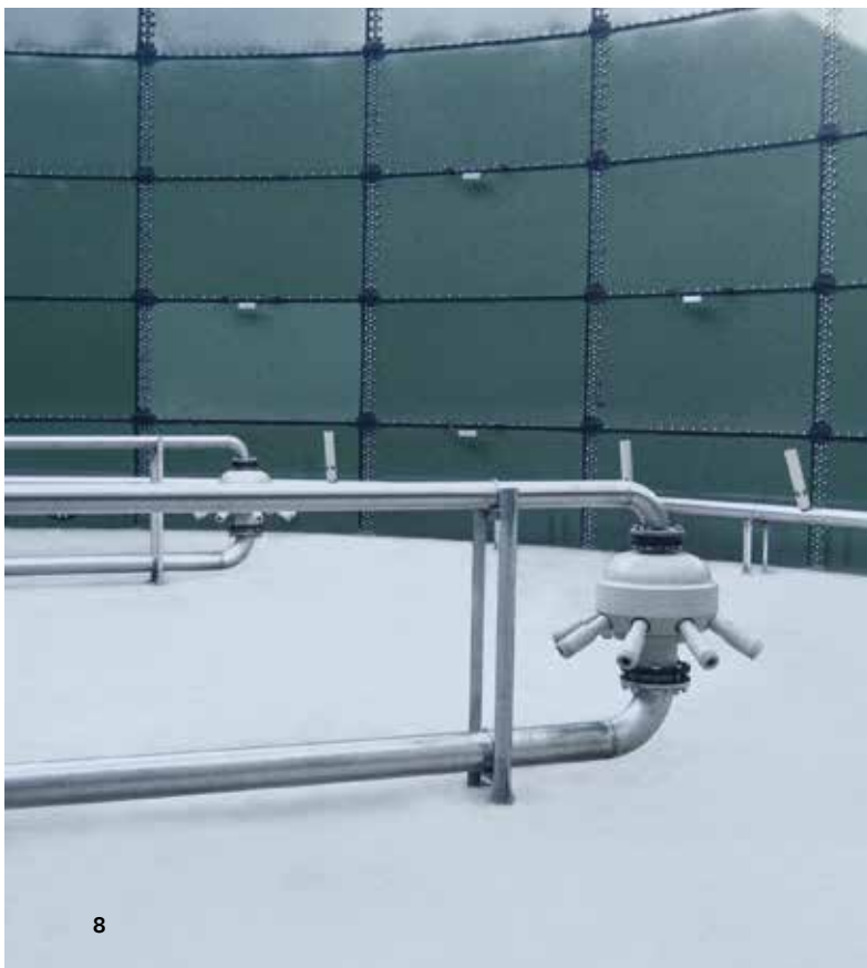
射流器和混合喷嘴应用于池内 SBR 批序反应器中
