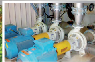
位于斯特拉斯堡的“Blue Paper SAS”纸厂 4 000 m 3 的清水滤液罐的一套 3 台水喷射气体压缩机，每台压缩机由一台循环水泵提供动力。
