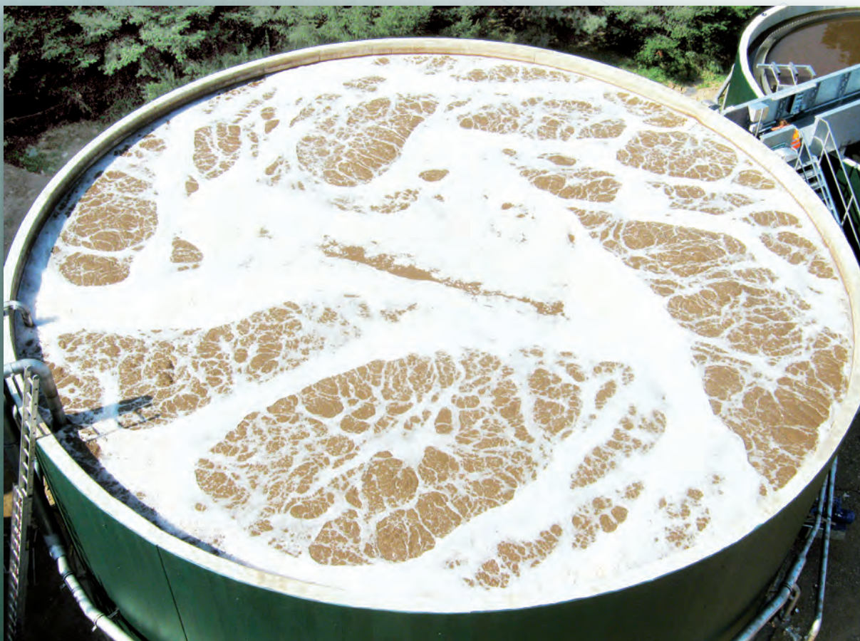
在 1 200 m 3 造纸污水曝气罐
